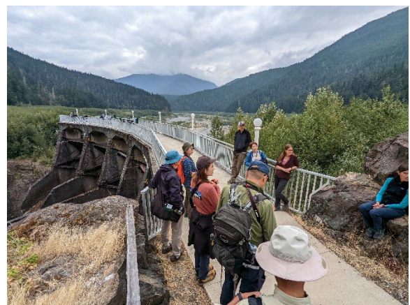
ダムの遺構は教育のために残されている
